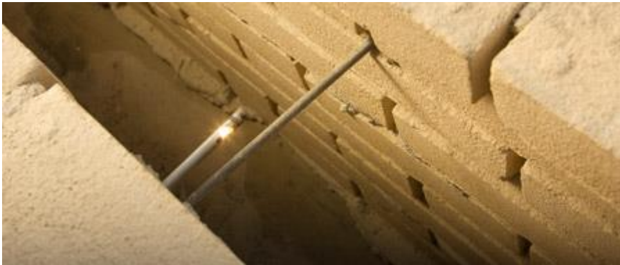
Spouwankers in de spouwmuur
