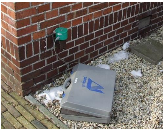
Het meten van trillingen op een gevel.
